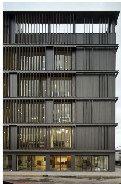
Lameller foran vinduerne
