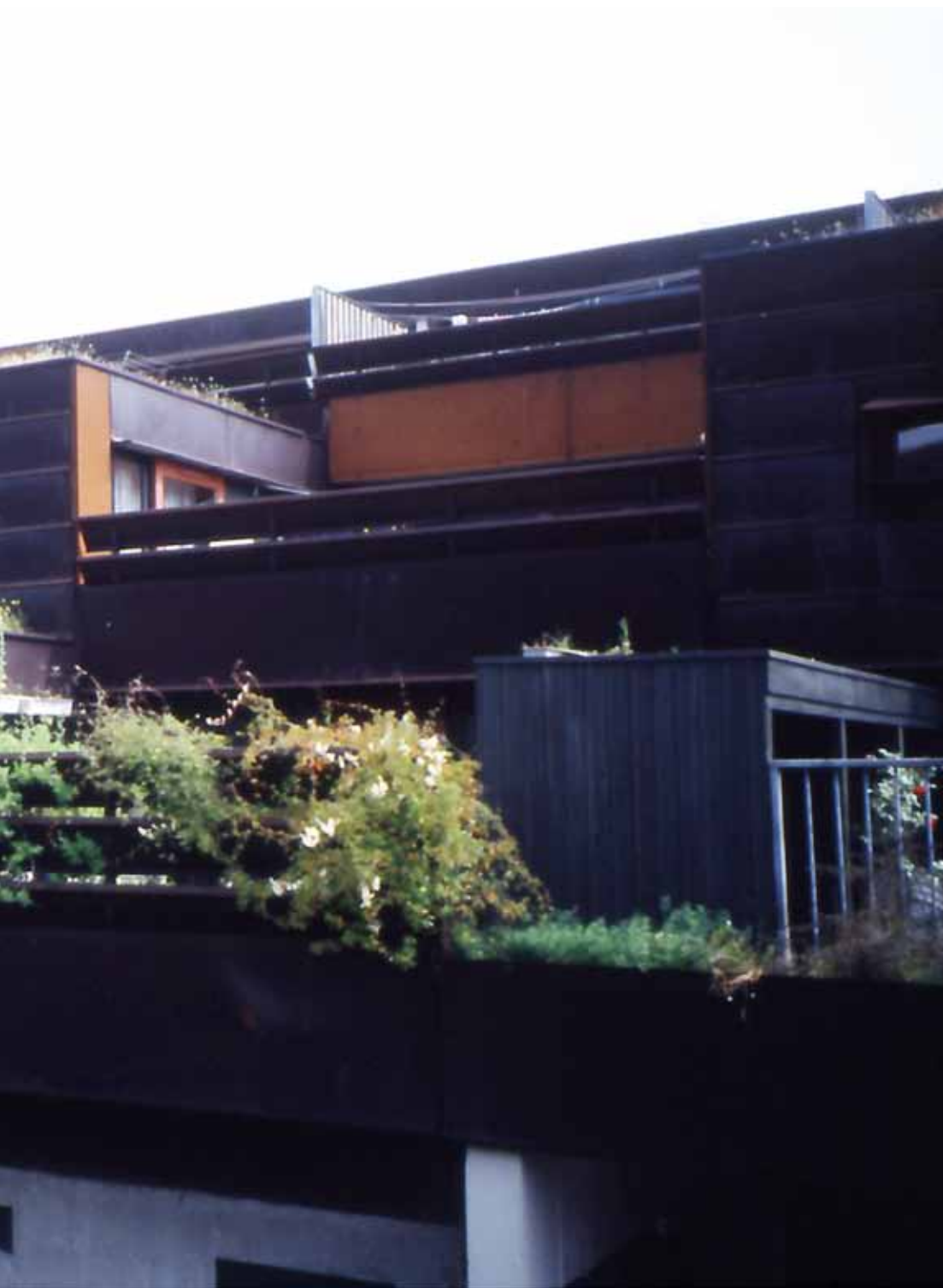
Farum Midtpunkt, der er opført i starten af 1970'erne, består af 27 blokke med terrassehuse.
